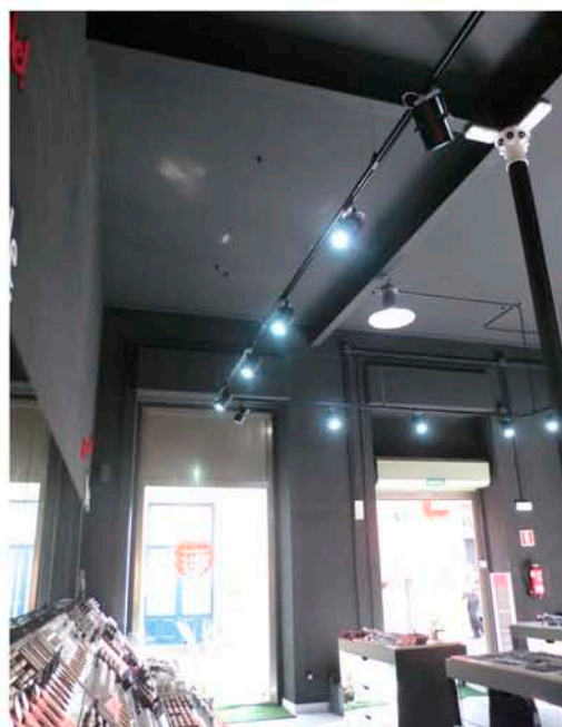
Instalación de campanas high power LED (90W) en la tienda IT Style en Triana (Gran Canaria)
