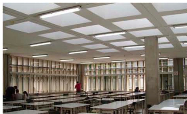
Instalación de tubos LED SMD en la facultad de arquitectura de la ULPGC
