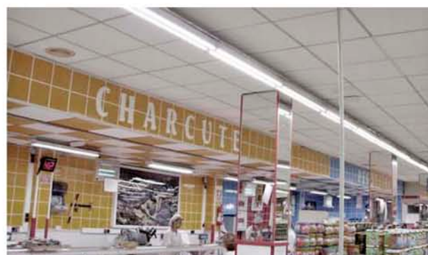
Instalación de tubos LED SMD en el supermercado "Alteza" de la cadena Jesumán.
