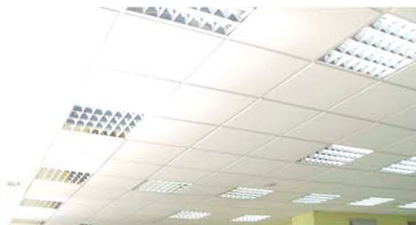
Instalación tubos LED SMD en Daily Price
